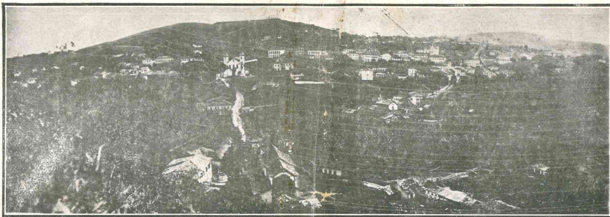
Vista geral da cidade, tomada do alto do morro "Cri-Cri". Na parte mais alta está o grande cemiterio de muros de pedras, construido, em maxima parte, a expensas do dr. Andrade. A soberba capella gothica, de pedras e tijollos, se deve a dom Epaminondas Nunes.
