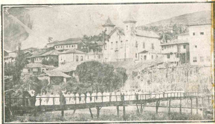
Vista parcial. Ponte de comunicação entre o Asylo e a Santa Casa.
