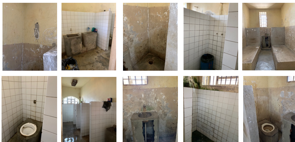
Área de banho e sanitários, celas coletivas
