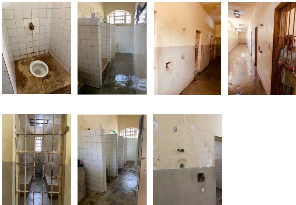
Banho e sanitário isolados
