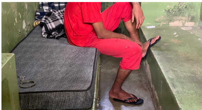
Algemas e ganchos instalados na alvenaria da cama para contenção no “isolado”
